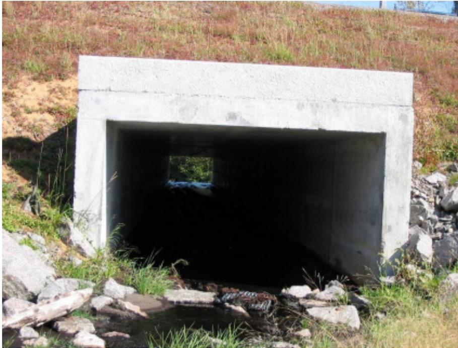
**Figure 3.2 : Ponceau rectangulaire en béton armé (Source : MTQ)**
