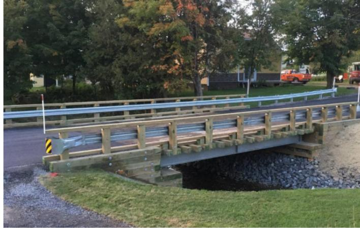
**Figure 3.1 : Pont acier-bois construit selon les règles de l'art (Source : MTQ)**
