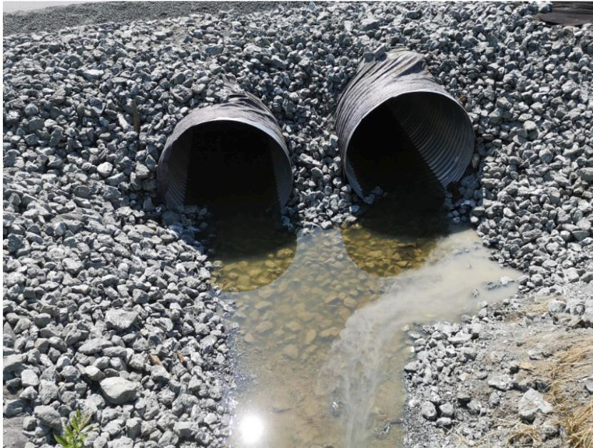
**Figure 3.3 : Batterie de deux ponceaux en tôle ondulée de 2,0 m de diamètre**
